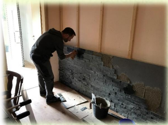
Anbringen einer Natursteinwand
